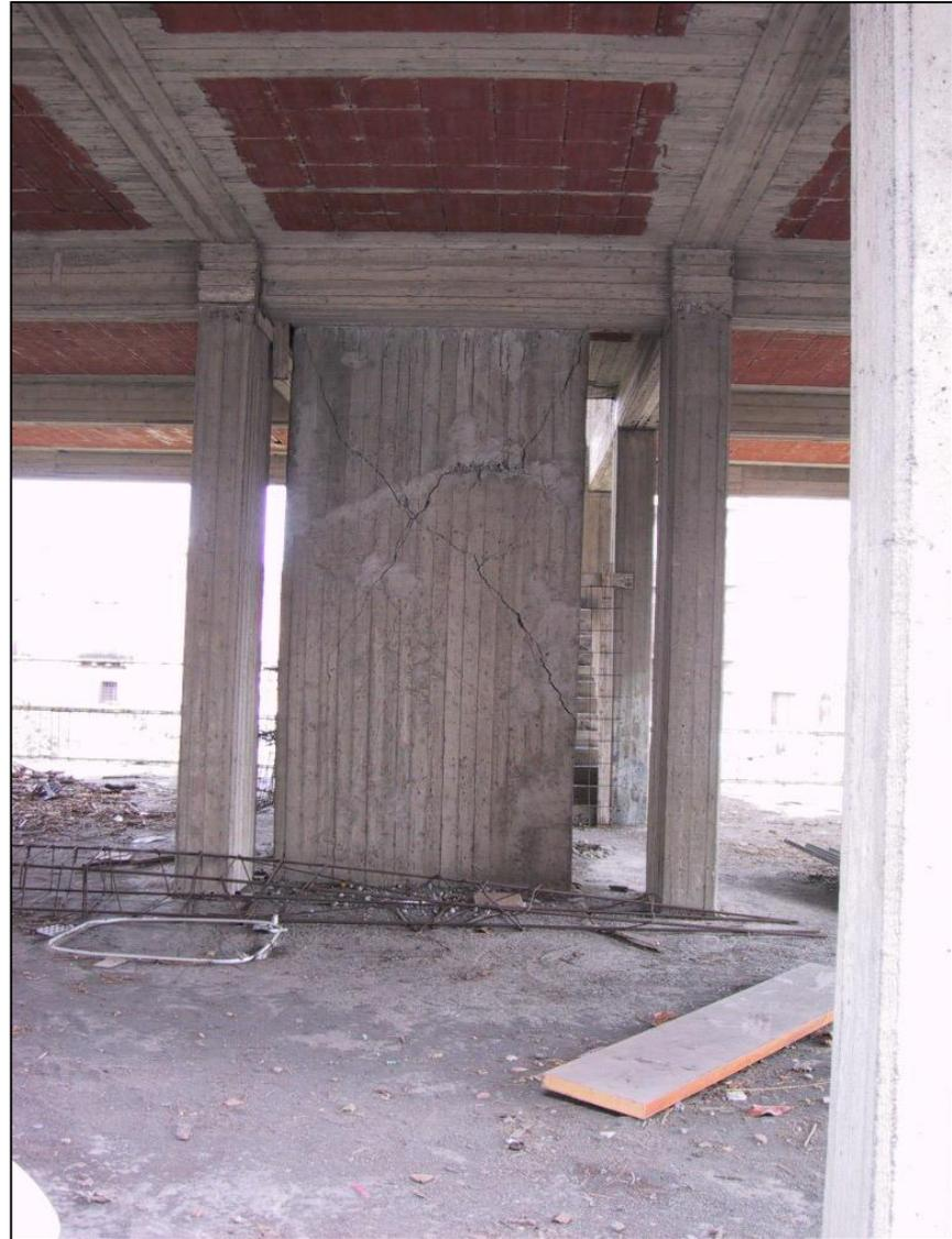
Doppia rottura diagonale per taglio su un nucleo in c.a..
