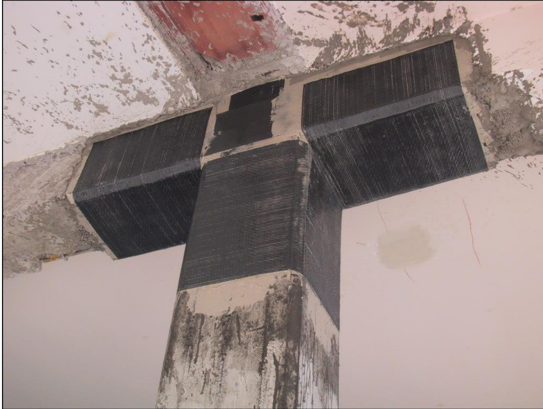
Fasciatura di un nodo trave-pilastro con fibre di carbonio
