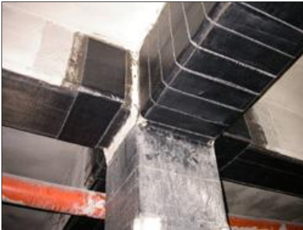
Fasciatura di un nodo trave-pilastro con fibre di carbonio
