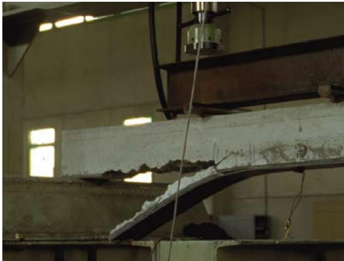
Distacco delle fibre di carbonio
