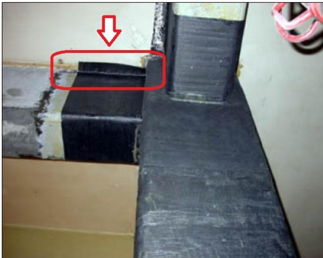
Fasciatura di un nodo trave-pilastro con fibre di carbonio
