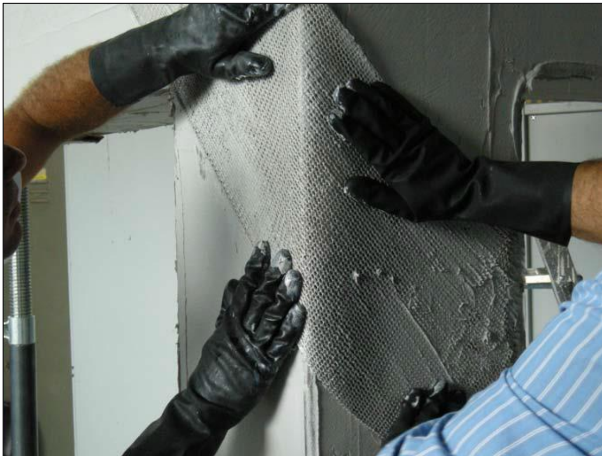
Confinamento del nodo Trave-Pilastro con fibre d'acciaio
