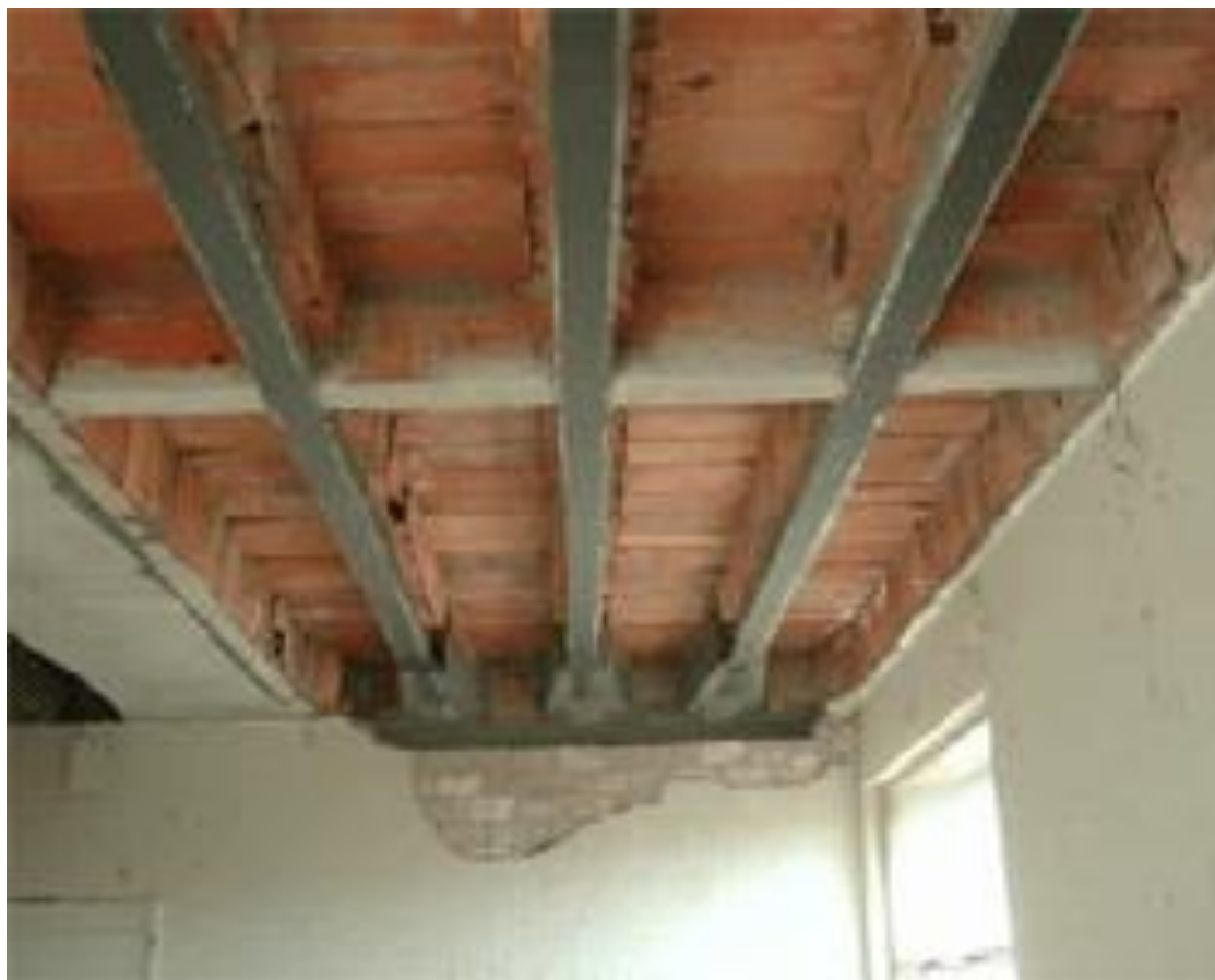
Rivestimento dei travetti di un solaio con fibre di carbonio
