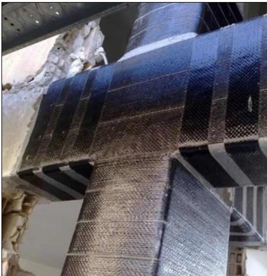
Confinamento del nodo Trave-Pilastro con FRP
