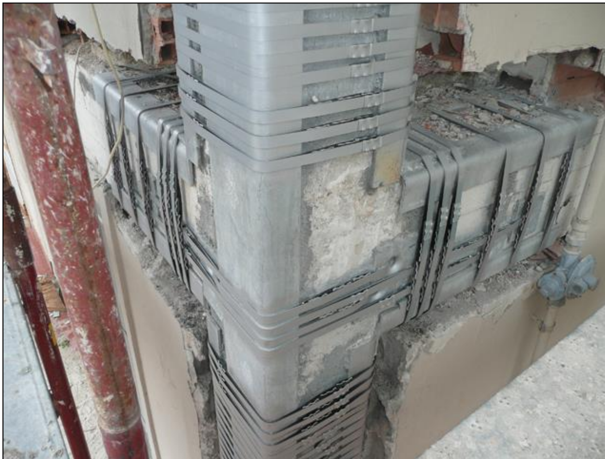
Confinamento del nodo Trave-Pilastro con CAM
