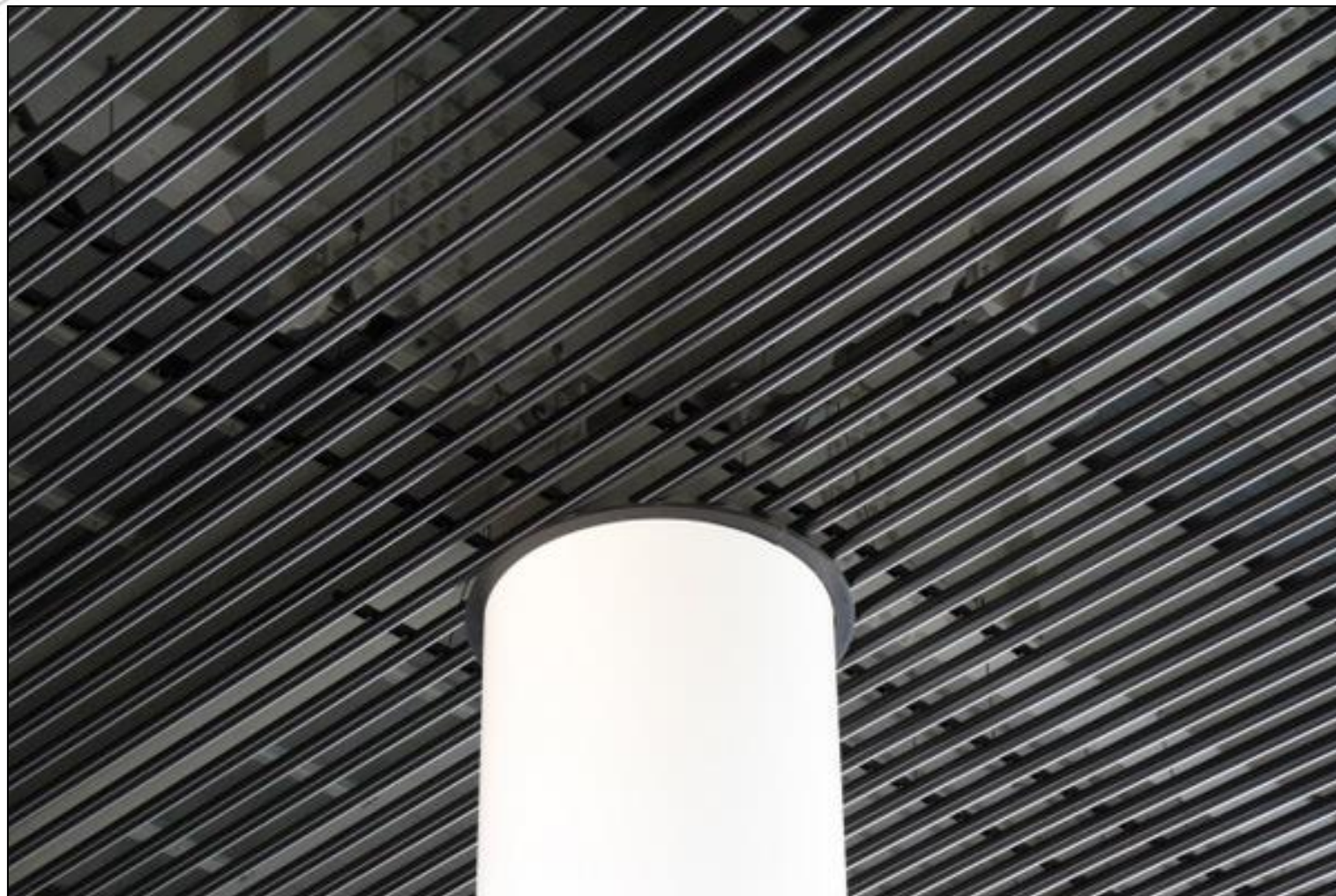
Dissipatori idraulici su copertura (Aeroporto di Catania)
