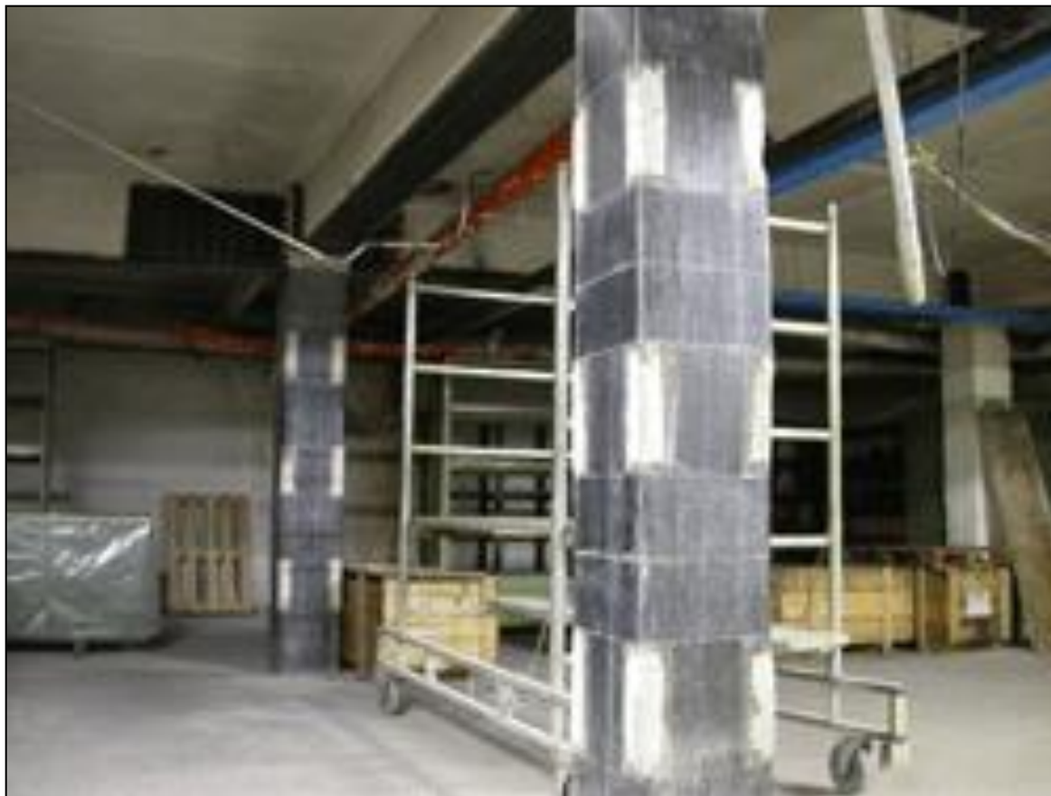
Fasciatura di un telaio con fibre di carbonio
