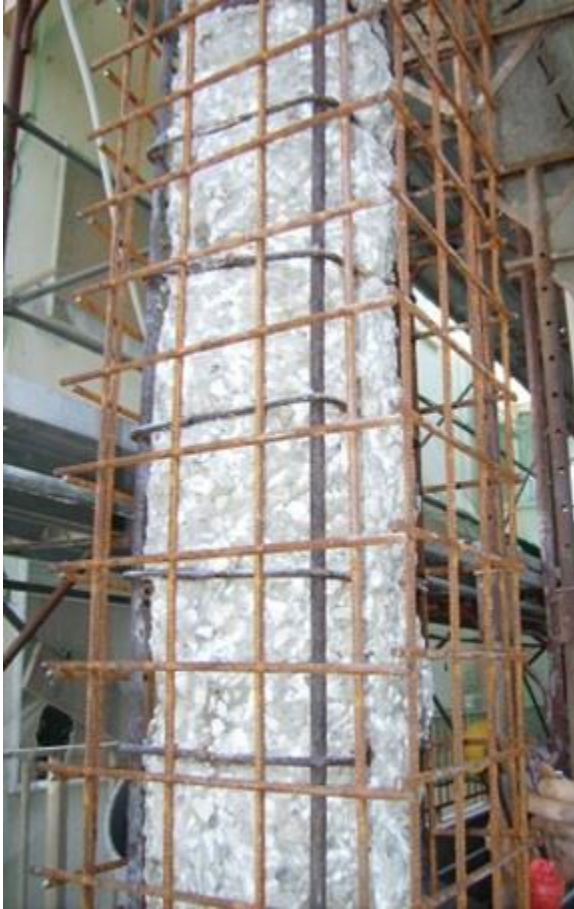
Incamiciatura pilastro
