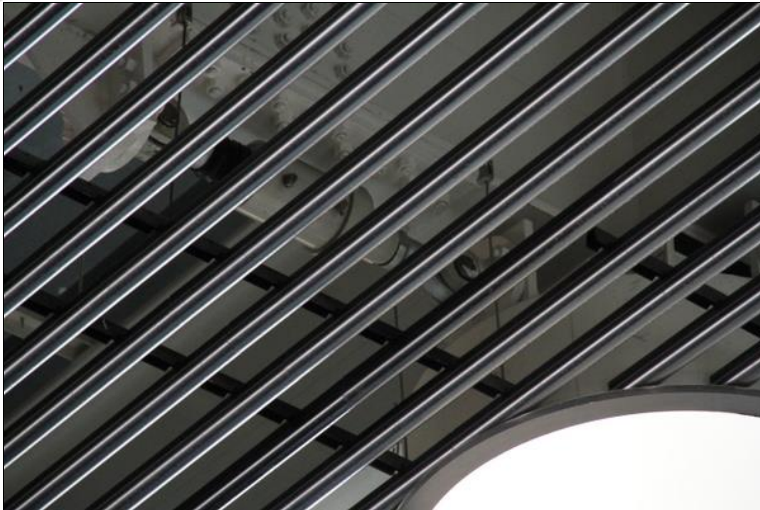
Dissipatori idraulici su copertura (Aeroporto di Catania)
