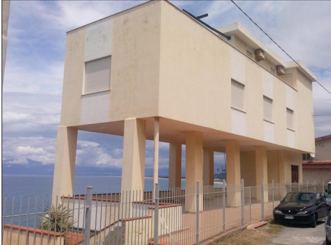
Incremento del 40% delle azioni di calcolo sugli elementi verticali (pilastri e pareti) dei piani soffici.
