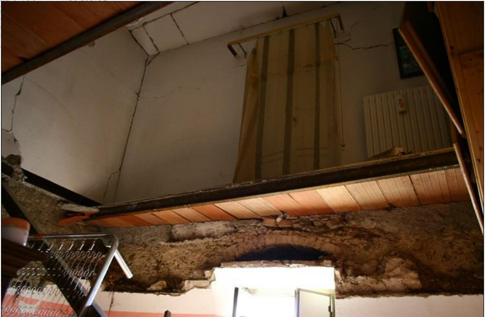
Collasso del solaio per insufficiente ammorsamento sulle pareti
