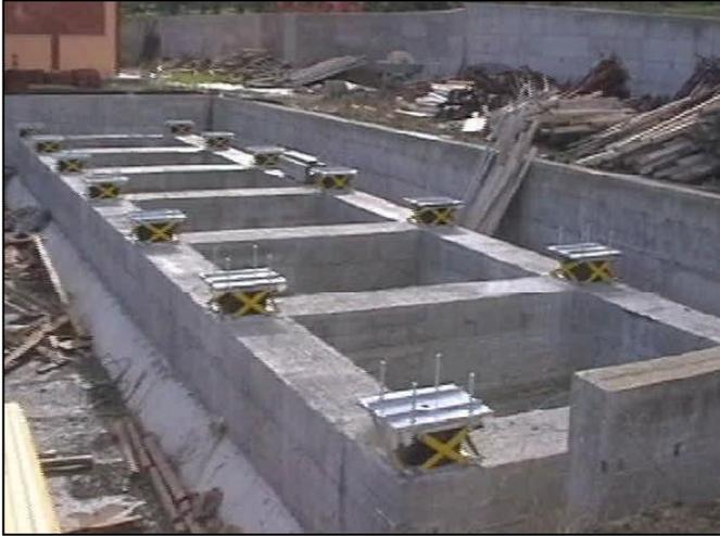
Deve essere garantita la **rigidità strutturale nel piano orizzontale** dei piani immediatamente al di sotto e al di sopra del sistema di isolamento, al fine di garantire una distribuzione regolare degli sforzi tra i diversi isolatori ed a distribuire correttamente le forze degli eventuali dispositivi ausiliari (che sono in genere in numero limitato) tra gli elementi strutturali che debbono assorbirli.
