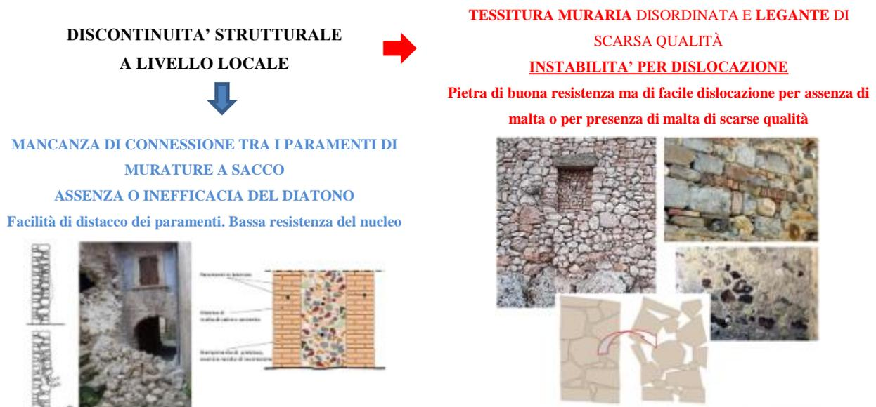
**Fig. 4- Meccanismi di rottura fragile per disgregazione della massa muraria**
