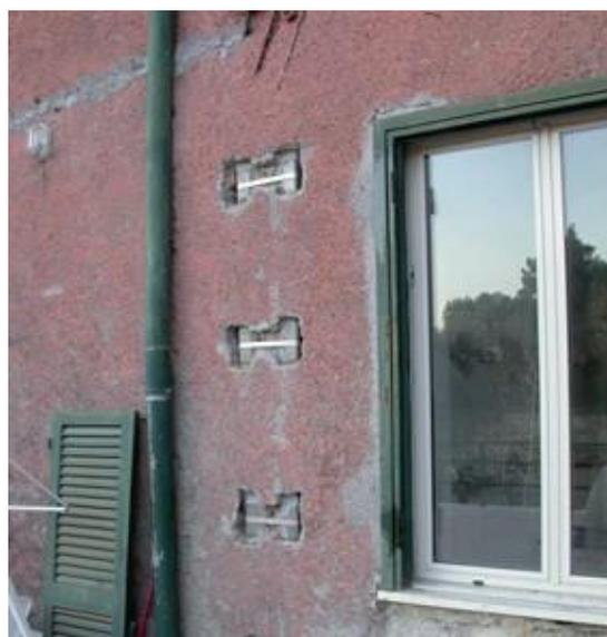
**Fig.11 – Realizzazione di Incatenamenti con il Sistema a marchio CAM®.**
