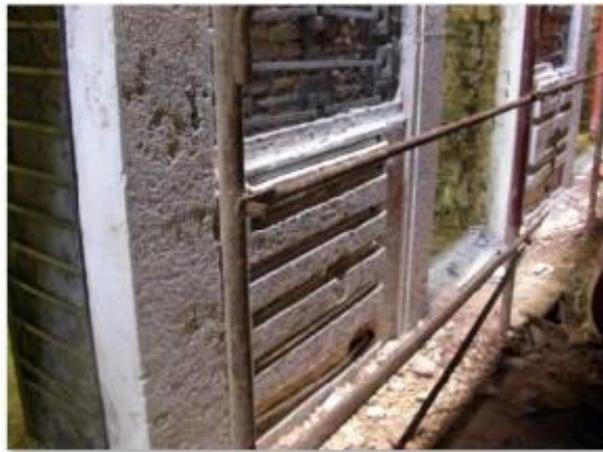
**Figura 22: Dettaglio dell'intervento in facciata e conservazione delle cornici in marmo**
