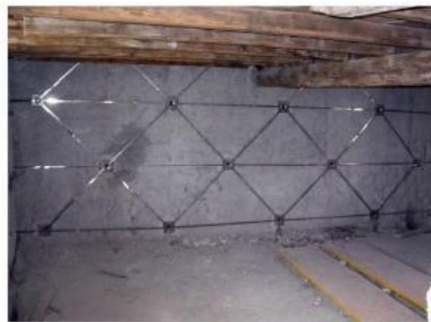
**Figura 21: Una parete di sottotetto, trattata con nastri diagonali**
