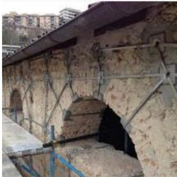
**Figura 32 : il particolare del rinforzo sulle aperture ad arco.**
