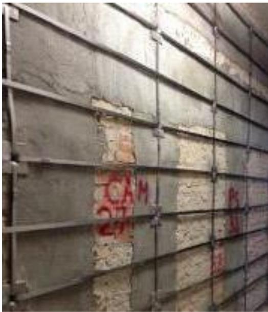
**Figura 29: Intervento con infittimento delle legature orizzontali**
