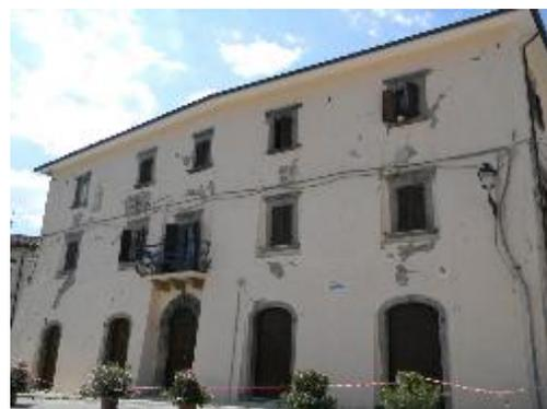
*Fig. 2- Rotture fragili su edifici in muratura*
