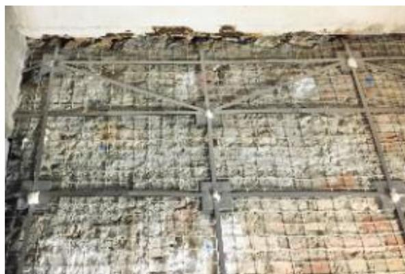
*Fig.9 – Esempio di applicazione della rete TENAX-RF2 al di sotto della maglia.*
