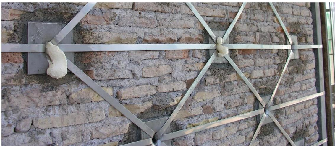
*Fig. 6 – Esempio di applicazione anche diagonale*
