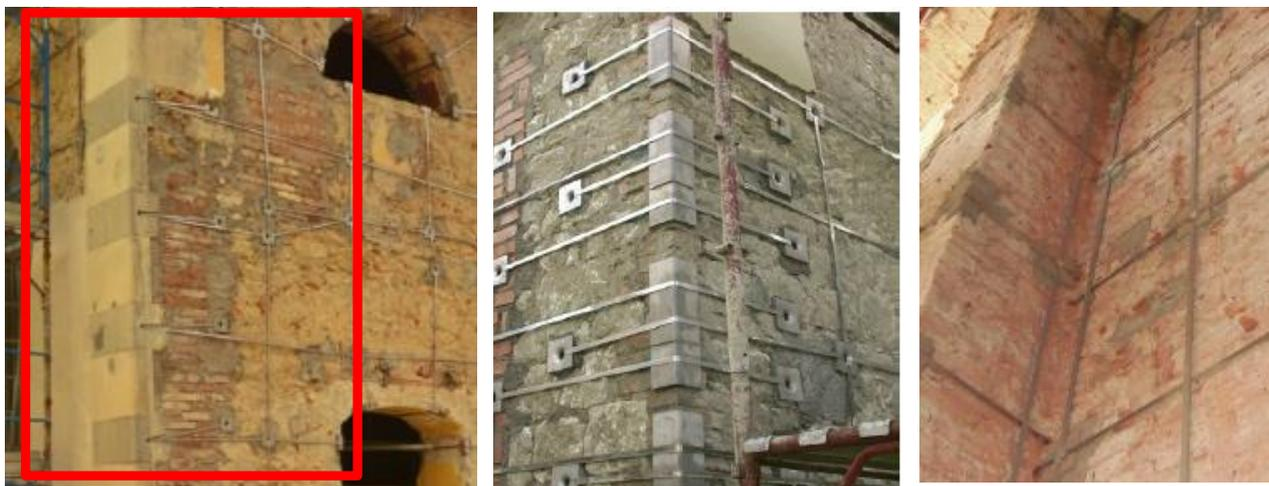
*Fig.12 – Particolari di ammorsamento in corrispondenza di incroci murari.*
