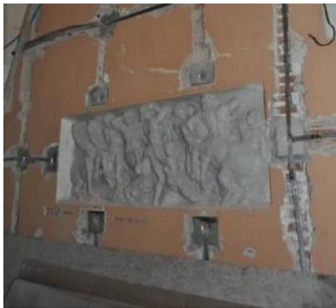
**Figura 27 : Passaggio dei nastri in conservazione di un bassorilievo**
